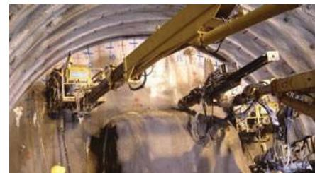
写真-1 鏡ボルト施工状況
